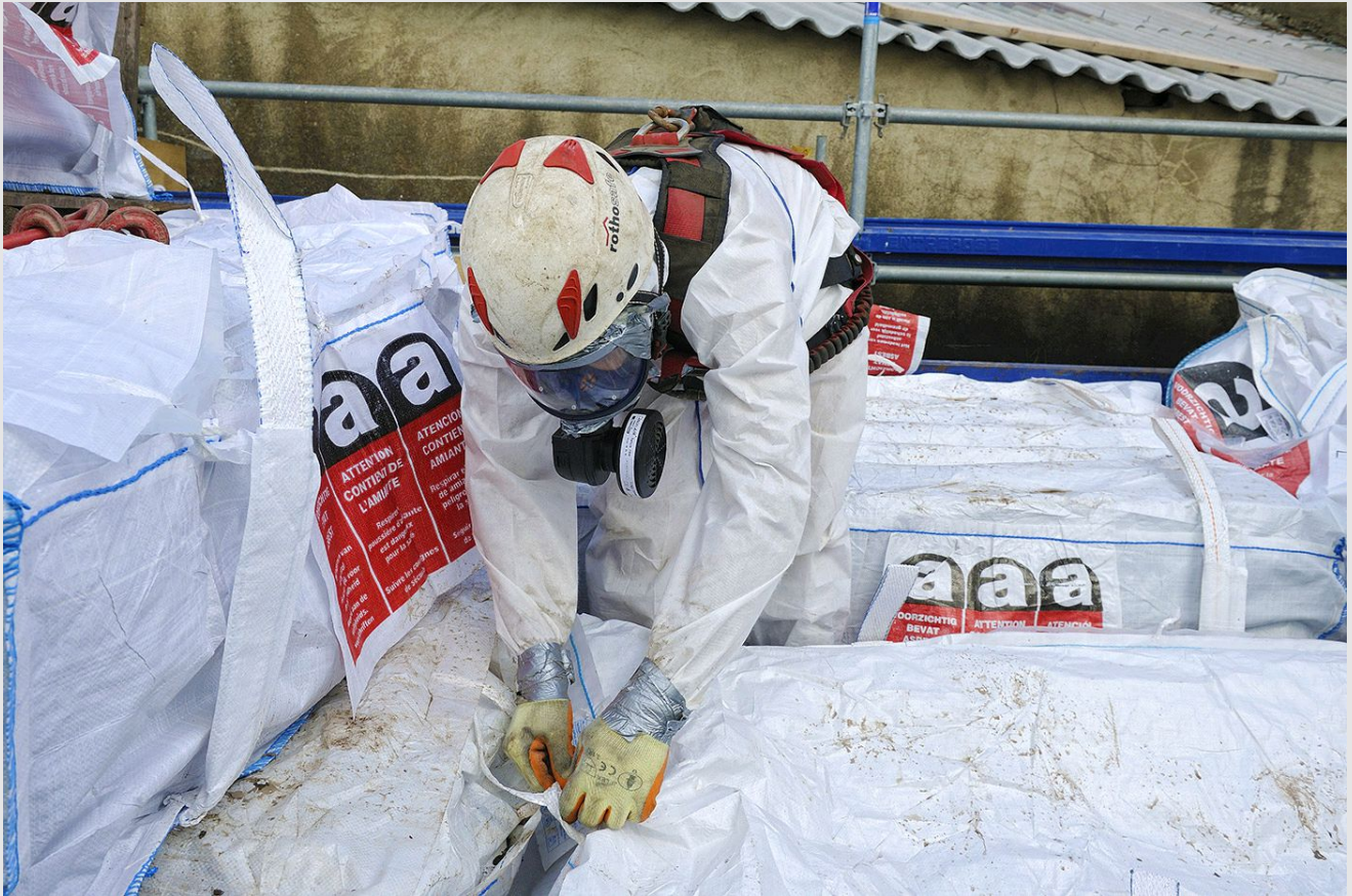
Fermeture d'un « big bag » de déchets d'amiante sur un chantier de remplacement de toiture amiantée
